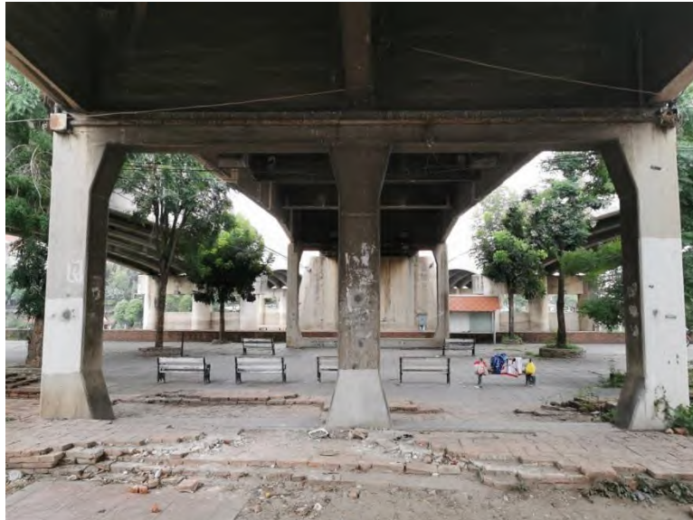
รูปที่ 8-145 โครงสร้างตอม่อของสะพาน Approach Bridge
