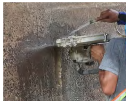
(ฉ) การตัดเหล็กเสริม
