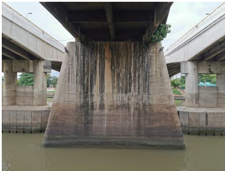
รูปที่ 8-146 โครงสร้างตอม่อของสะพาน Tie - Arch Bridge
